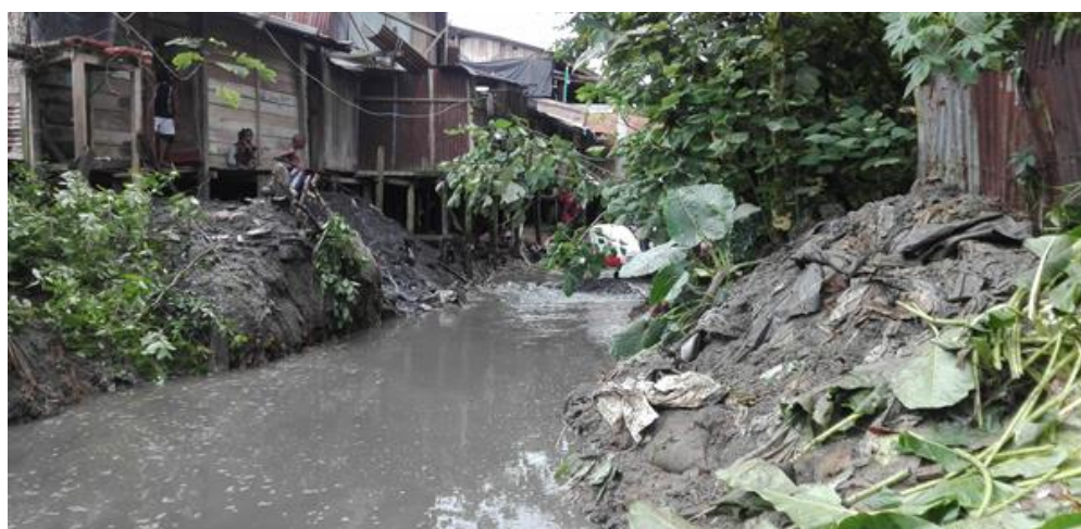
Fotografía 11 Limpieza y destronque de la quebrada La Cazcorva
